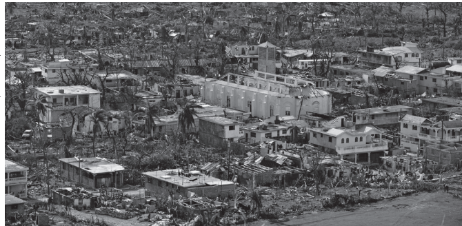
Casas destruídas pelo furacão Matthew. Haiti, 2016.
